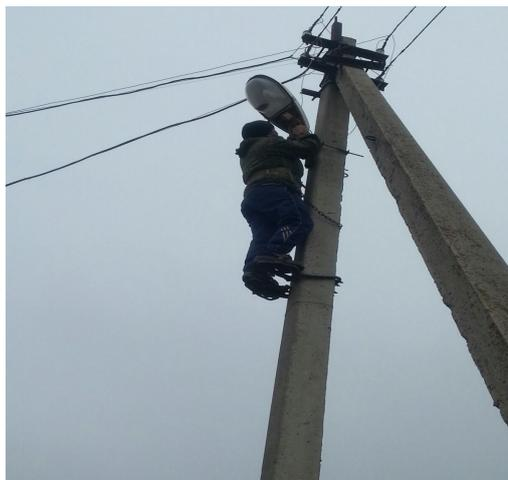
22 января в селе были проведены ремонтно-профилактические работы уличного освещения. Были заменены реле-регуляторы и лампочки на "кобрах"
